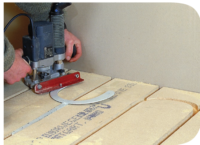
Man fræser selv sine vendespor i DLH Thermogulv
